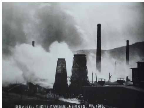
Obrázek :: Abbildung 2 Požár ústecké chemičky :: Brand der Aussiger Chemiefabrik
